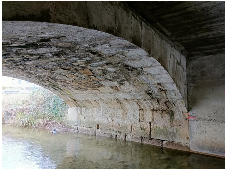
Erosion des joints en partie centrale
