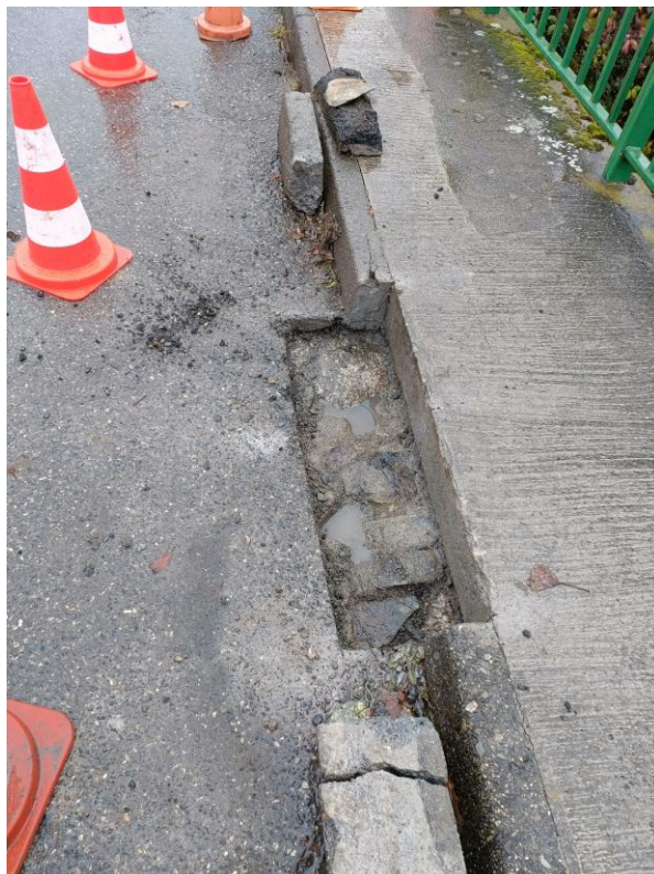
Erosion des joints en partie centrale
